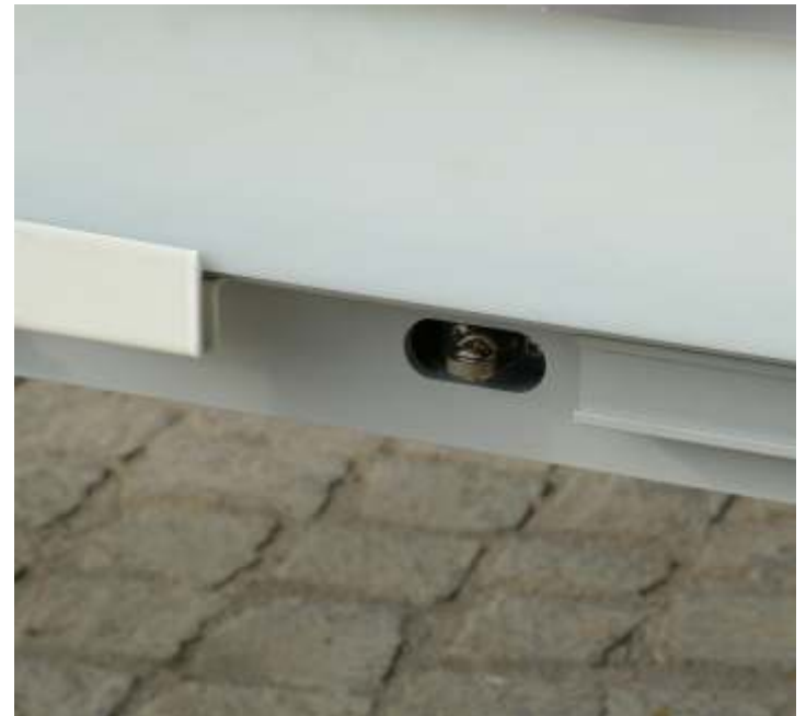
Particolare: micro di interruzione della tensione ad apertura anta.
